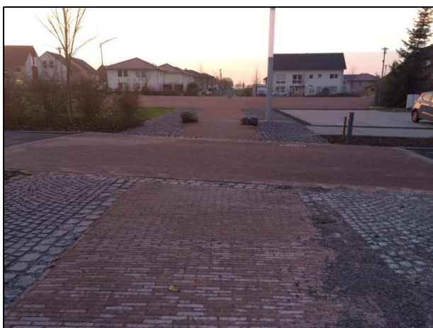
Blick auf den Überweg in Richtung Quartiersplatz
