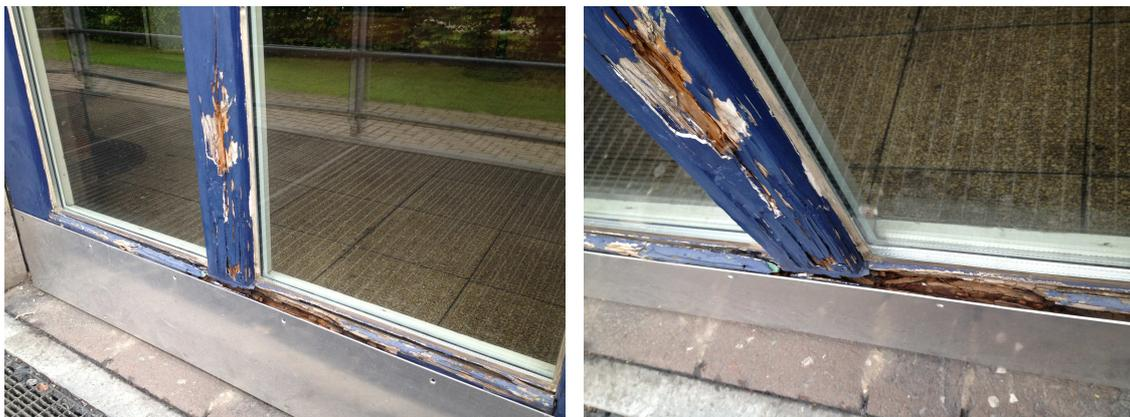
*Starke Schäden an den Türen im Foyer (witterungs- und verschleißbedingt)*
