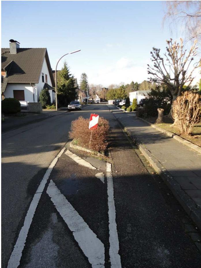
Abb. 5: Fahrbahnteiler (links Fahrbahn, rechts Radweg)
