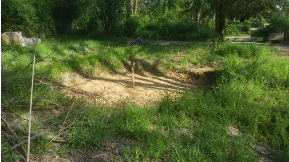
Bild 3: Grillplatz, Grube ausgehoben, Kies eingebracht
