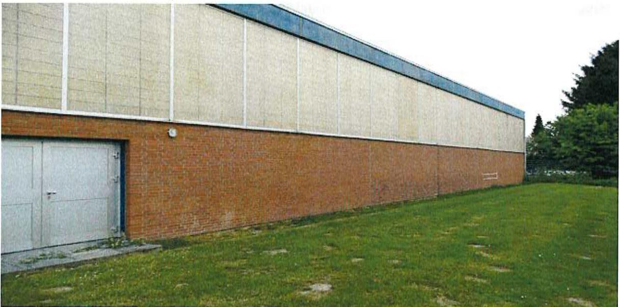
Im Rahmen einer Dachsanierung müssen sich, nach Rücksprache mit der Fa. Eismar, einhergehend Gedanken zur Sanierung der Kunststoffelemente gemacht werden. Wird das Dach erneuert, bilden die Kunststoffelemente die neue Kältebrücke.
