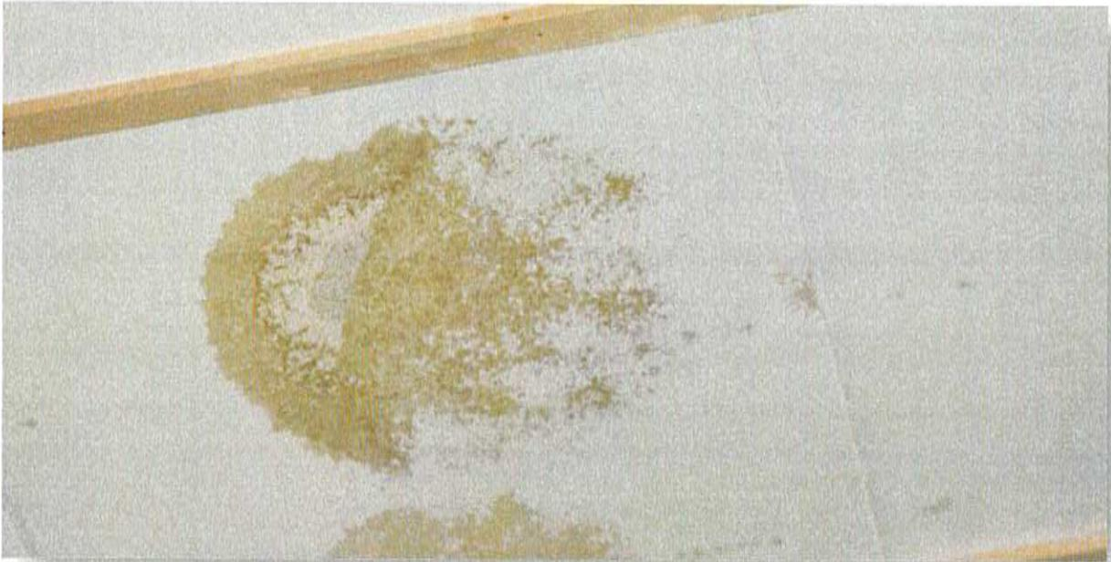
Das Dach wurde nach Rücksprache mit der Gemeinde durch die Firma Eismar geöffnet. (Diese Flecken sind allerdings nicht dort entstanden, wo die Fa. Eismar das Dach öffnete, sondern wahrscheinlich im Bereich eines Lüfters, welcher mittig auf dem Dach steht. Fa. Eismar öffnete das Dach im Randbereich.)
