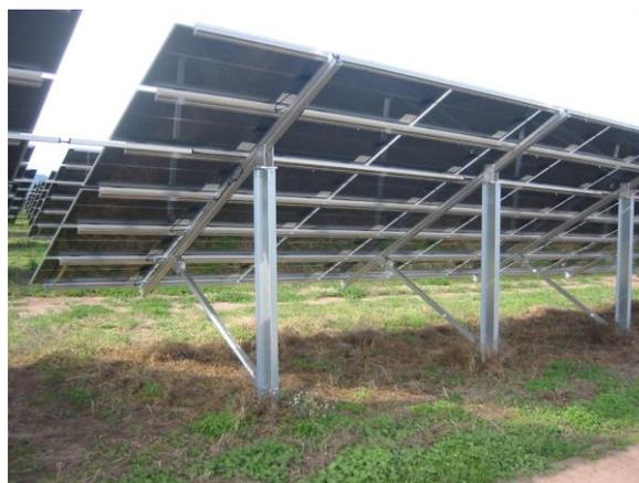
Die Module werden parallel in südliche Richtung mittels Leichtmetallkonstruktion mit einem fest definierten Winkel zur Sonne nach Süden hin aufgeständert (siehe Bilder). Die Module werden auf so genannten „Modultischen“ angeordnet, welche auf in den Boden gerammten Metallpfosten befestigt sind.
