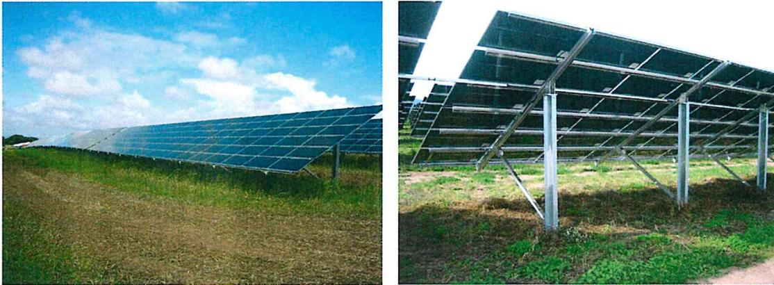
Die Module werden parallel in südliche Richtung mittels Leichtmetallkonstruktion mit einem fest definierten Winkel zur Sonne nach Süden hin aufgeständert (siehe Bilder). Die Module werden auf so genannten „Modultischen“ angeordnet, welche auf in den Boden gerammten Metallpfosten befestigt sind.
