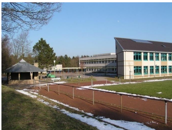
Blick auf das Schulzentrum Hürtgenwald, vorne rechts Realschule, dahinter die Hauptschule
