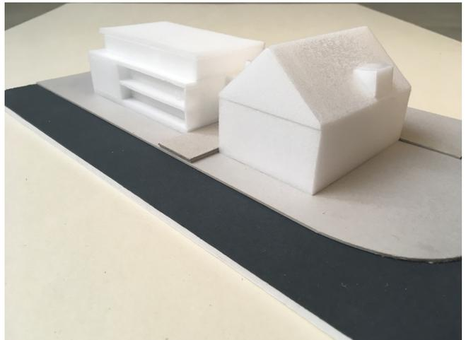
VARIANTE 2, Dachgeschoss mit Satteldach, Dachneigung 38°
